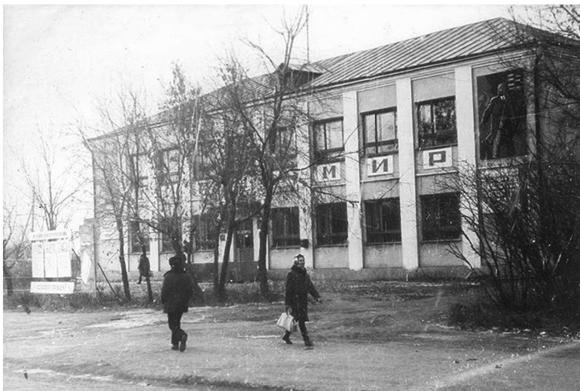
Здание РУС. 1975г. В настоящее время в этом здании располагается суд.
