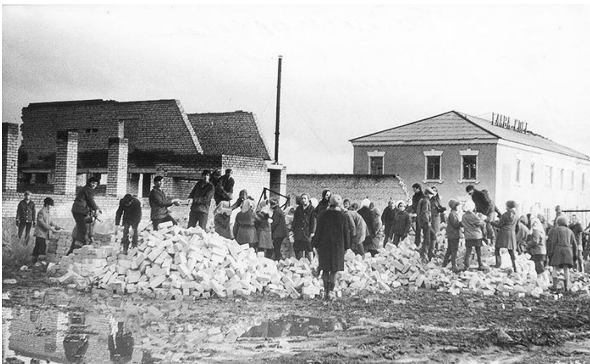
Татищевские школьники на ударнике на строительстве ДК.03.11.1973 г.
