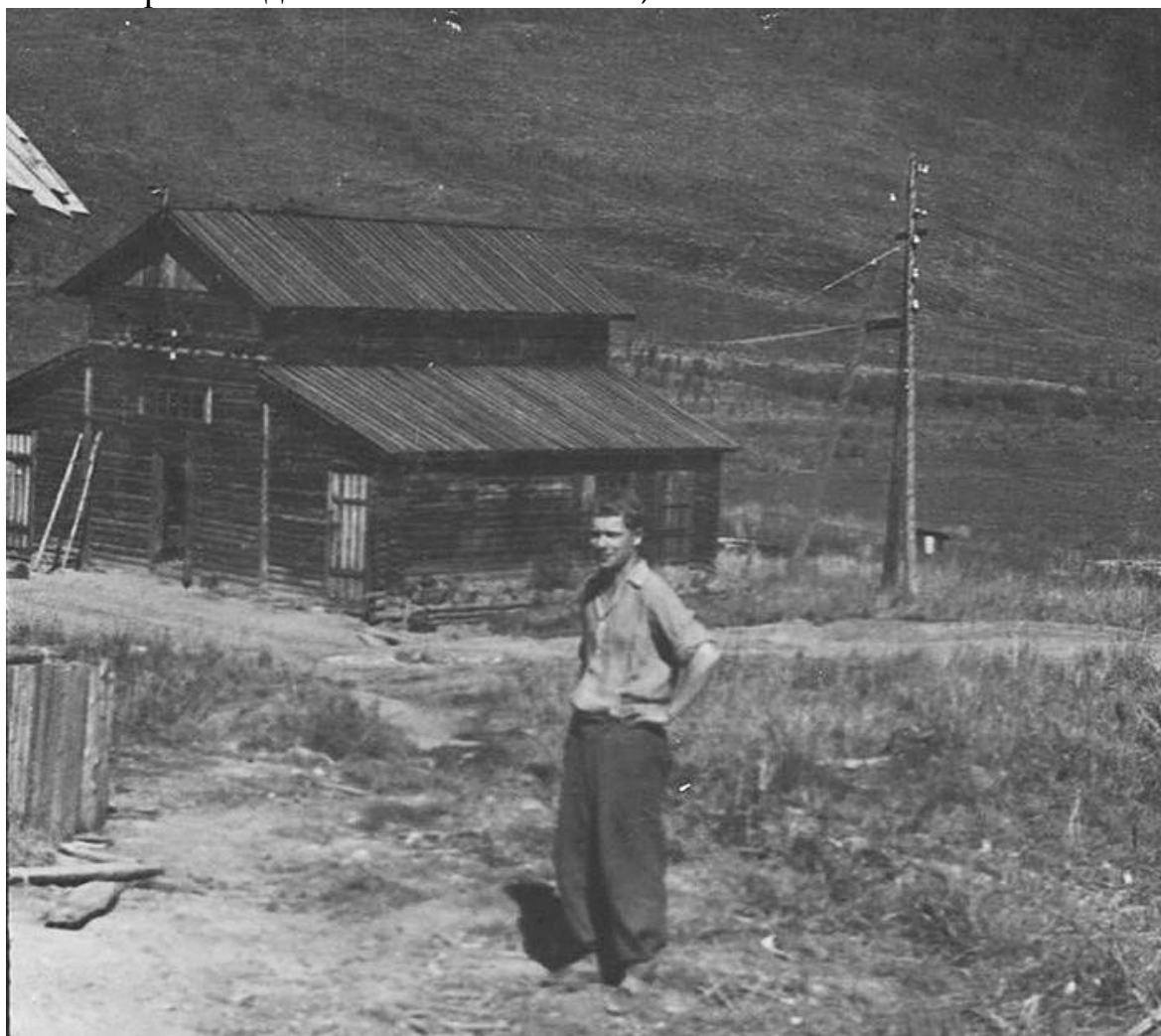
Подстанция Ольчан. Индигирка. Якутия. Август 1955 г.
